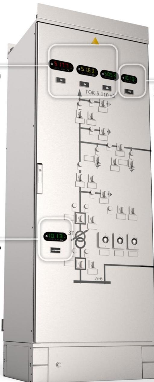
Для устройств РПН с датчиком положения типа "токовая петля" (0..20 мА; 4..20 мА) доступно применение ИРИС-О2 в качестве индикатора положения РПН. Для этого уставке "I1min" нужно присвоить номер нижней ступени, "I1max" - номер верхней ступени, и настроить индикацию прибора на отображение целых величин.
